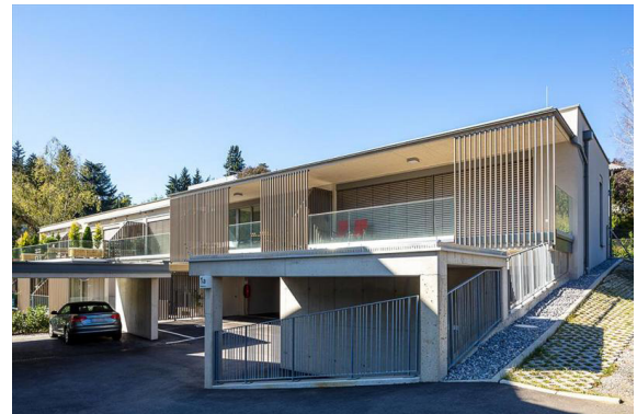
Massivbau mit 12 Wohneinheiten Photovoltaik / Wärmepumpe / Heizstab / E-Laden
